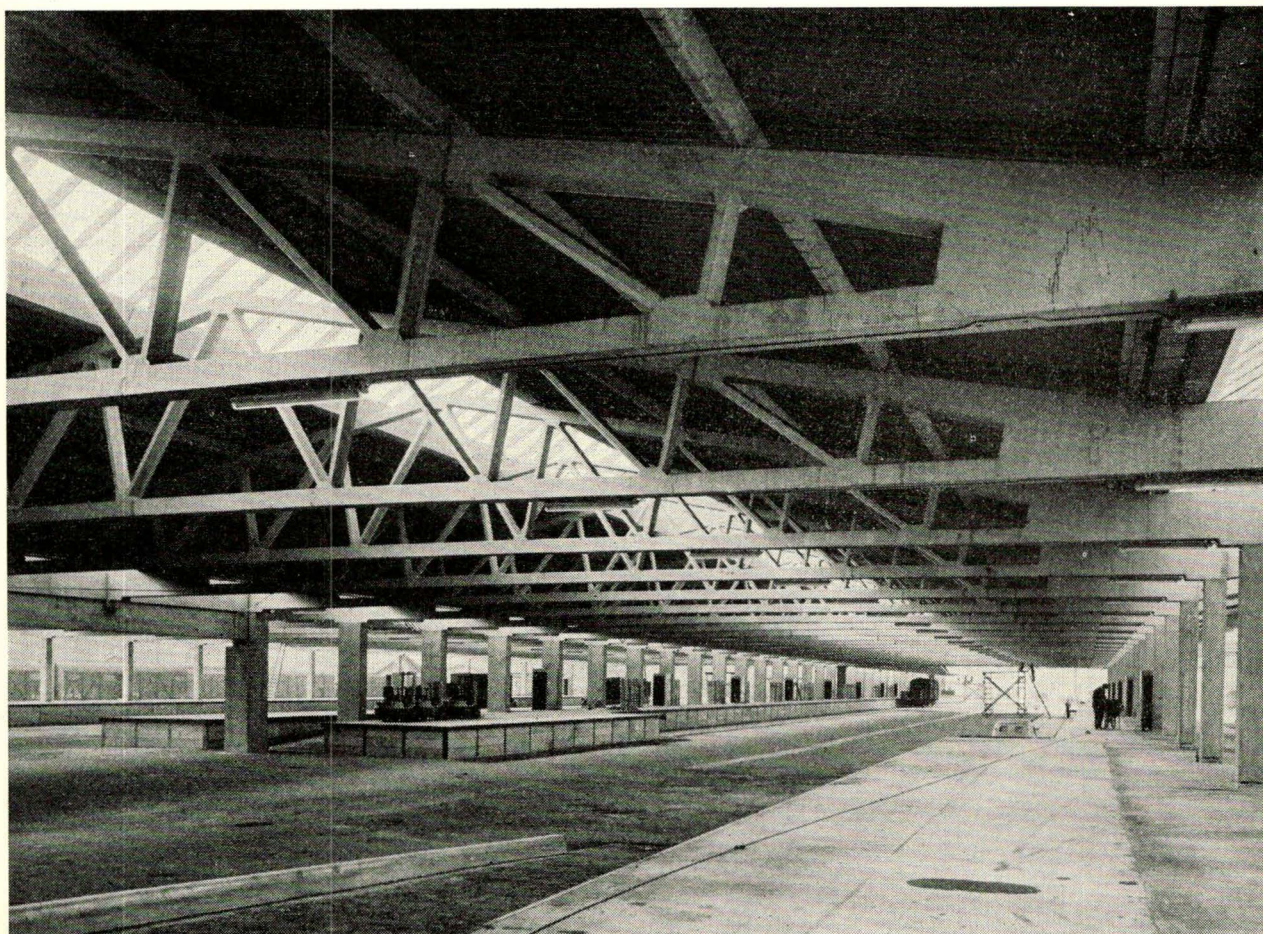
Den vældige overdækning med de 29 m lange gitterspær.
